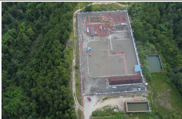
元坝 10-1H 集气站现场照片
